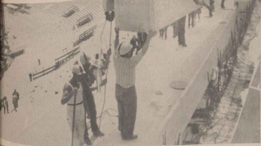
Los trabajadores ponen el último bloque, adornado con guirnaldas, para el estadio de los Juegos Olímpicos de 1972. Durante 60 días y noches han sido instaladas 1200 gradas
