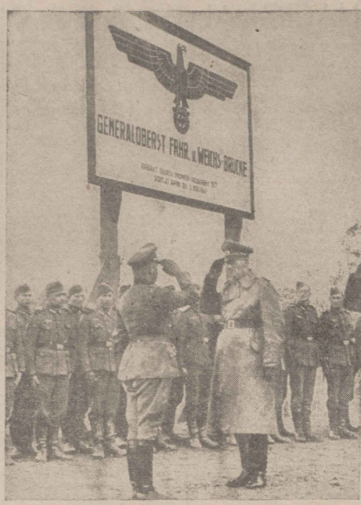
La inauguración del nuevo puente "Generaloberst Freiherr von Weichs" en Belgrado, recién reconstruido por los zapadores alemanes.
