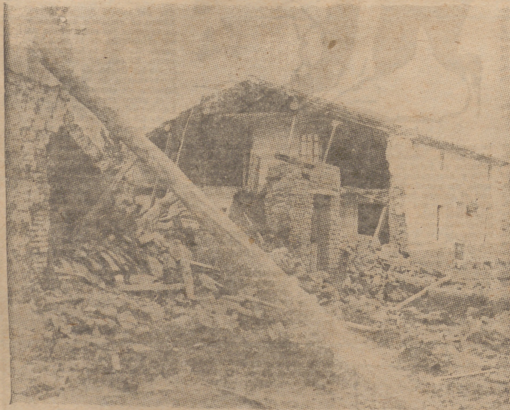
Ruinas, desolación, tristeza bajo el cielo plomizo de la tarde. Vigas astilladas, techos hundidos, paredes desmoronadas. Balance catastrófico de unas horas de riada vega abajo de Las Berlanas. (Foto Verdugo hijo.)
