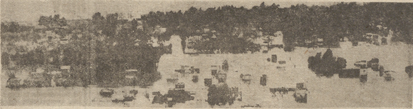
Esta es una de las zonas más bajas y más castigadas del sur de Buenos Aires, en la localidad de Ezpeleta, donde pueden verse las casas todavía inundadas, luego de comenzar a descender el nivel de las aguas. La presente fotografía ha sido tomada desde un avión, y da una idea de los alcances de la catástrofe que, a lo largo de 100 kilómetros de costa, ha dejado sin hogar a 100.000 familias argentinas.
