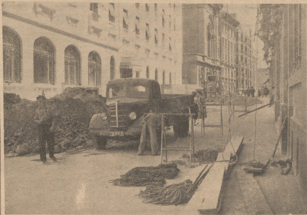
Aquí se abre una zanja, allí se levanta un andamiaje, en este lado se amontona la tierra y en aquel los adoquines. Aquí, allí, esto y lo otro son las aceras y calzadas de una calle estrecha como esta de la foto, y se corta la circulación total por la misma o surge la pregunta "¿a quien corresponde?": ¿Por dónde se pasa? La contestación, en la vía pública. (Foto Mamegam.)
