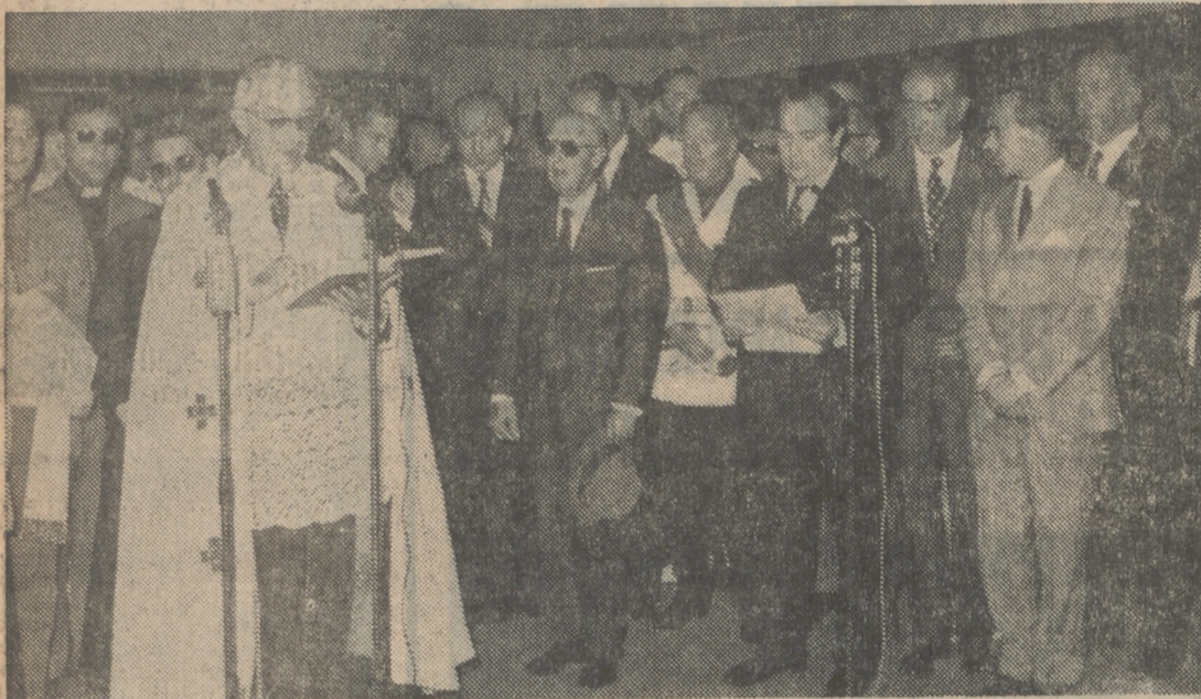
FRANCO, EN NOBLEJAS.—En presencia del Caudillo, varios ministros del Gobierno y demás autoridades, el cardenal primado de España, don Vicente Enrique y Tarancón, bendice las nuevas instalaciones del centro emisor de Noblejas
