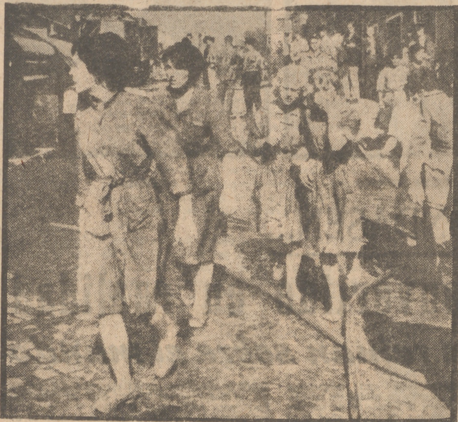
Más de un centenar de obreros y operarias de la fábrica de barnices de la populosa barriada de Valdecañas, fueron presa de gran pánico al oír la fuerte explosión seguida de un violento incendio. Dos operarios y un obrero encontraron la muerte y varios más resultaron heridos. La fotografía recoge el momento de hondo dramatismo en el que las operarias huyen despavoridas de la infernal hoguera
