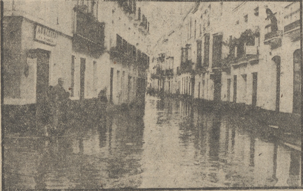
SEVILLA.—Una de las calles adyacentes a la Alameda de Hércules, situada ya en el casco urbano de la capital, inundada por las aguas desbordadas del Guadalquivir
