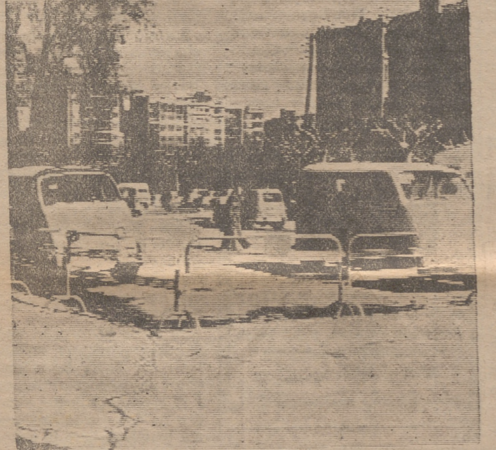
Parte de la plazoleta de la Gran Vía ha sido habilitada para aparcamiento de vehículos. A tal efecto, se han colocado las correspondientes vallas metálicas que cercan la zona elegida, neutralizando así el tránsito de peatones en evitación de posibles accidentes.-(Foto Albe).
