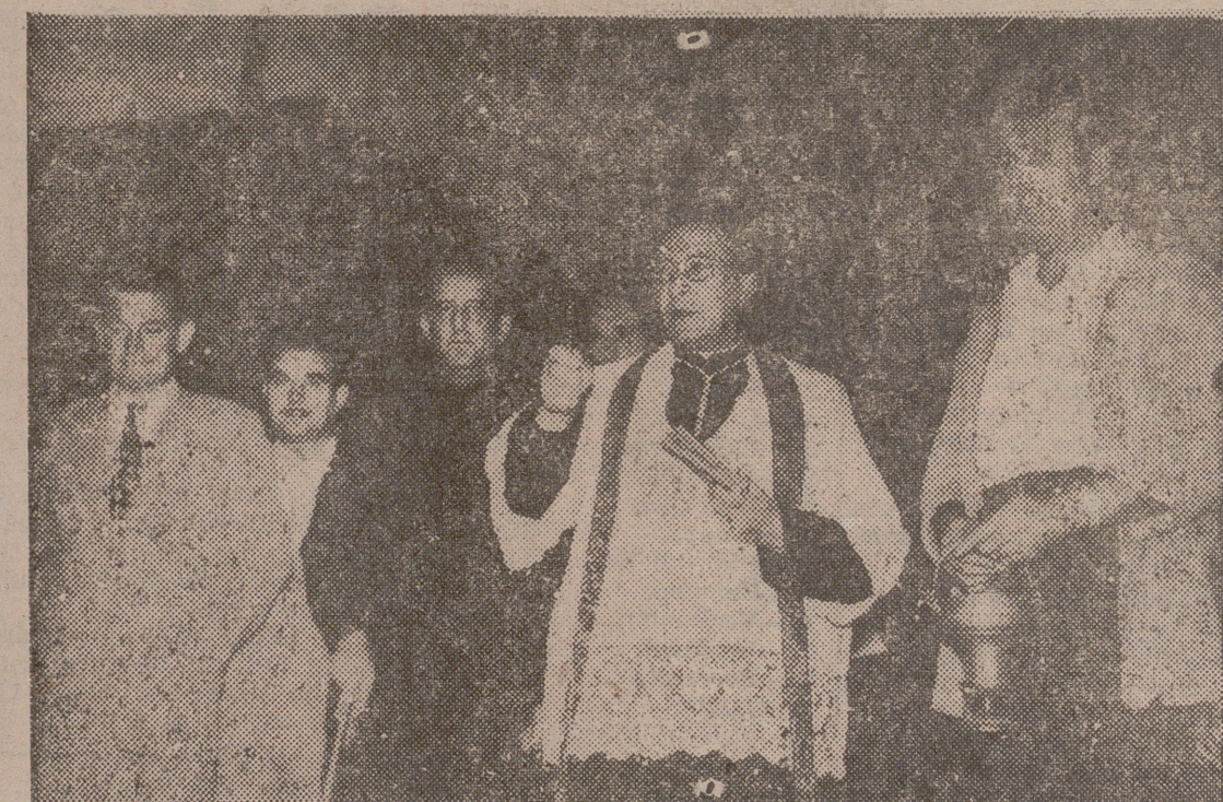
ALESANCO. --- Cuando está por la tarde, el excelentísimo señor gobernador civil preside en esta villa la bendición e inauguración de las obras de saneamiento y alcantarillas que tuvo lugar el día 15.
