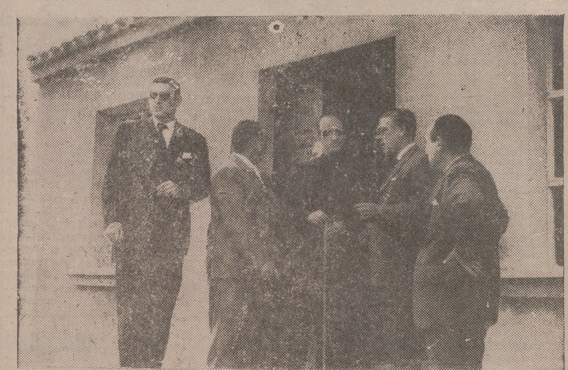
SAN ASENSIO. --- El excelentísimo señor gobernador civil y jefe provincial del Movimiento, don José Elorza Aristorena, acompañado del alcalde honorario, don José Iturrundi, y el efectivo, don Germán Villaro, comenta las instalaciones del nuevo Matadero Municipal, inaugurado el viernes.
