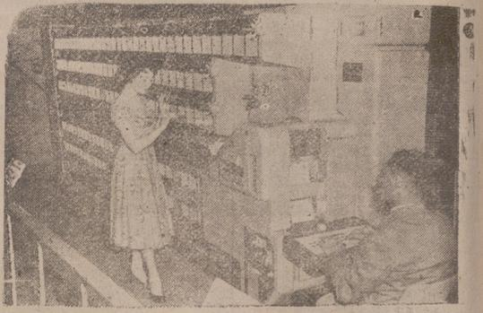
INGLATERRA. — Esta máquina que nos muestra la foto está bautizada con el nombre de "Elsie" y su misión es sacar, electrónicamente de sus sobres las cartas a una velocidad de 600 por hora. Después, con un pequeño cambio de sistema en su mecanismo, dobla, cierra y pega las cartas y las franquea para darlas curso. — (Foto Torremocha).
