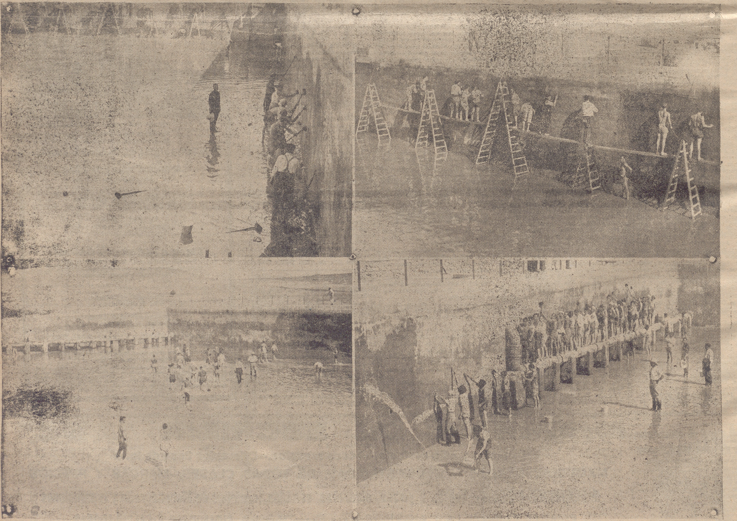
Ayer se procedió a una rápida limpieza del depósito grande del servicio de aguas potables de la ciudad. La labor era muy necesaria y había que realizarla tan concienzuda como presurosamente, a fin de que pudiera ser utilizado nuevamente a breve plazo. — Estimularon a los trabajadores el primer teniente de Alcalde don Enrique Amelvia y el gestor señor Gil López y el ayuntamiento obró de acaite tomando parte en la labor a fin de hacerse imitar. En estas fotos Limorti ha recogido algunos de los momentos del trabajo realizado bajo la carria de un sol picante, y los representantes del Ayuntamiento debieron quedar muy satisfechos del esfuerzo realizado en beneficio de la normalidad del abastecimiento y consiguiente del vecindario, pues obsequiaron a los obreros con unas riquísimas sopas con arroz, para añadir a su comida y un paquete de cigarrillos.
