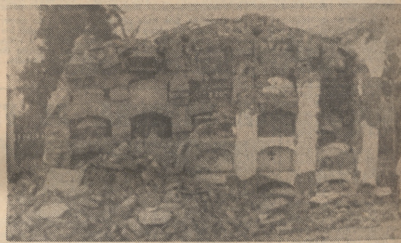
El cementerio de Sayan quedó en este estado tras el terremoto. En otro cementerio, el de Yungay, se resquebrajaron los 2.500 supervivientes de una población de 20.000 almas
