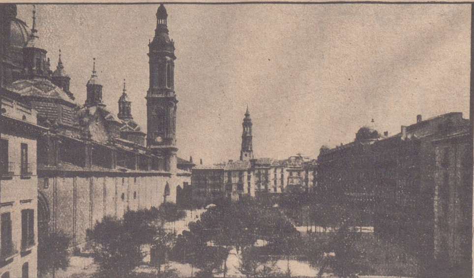
Antes de llevar a la práctica la mejora urbana de unir las plazas catedrales (comenzada a fines de 1939) así se encontraba la Plaza de Nuestra Señora del Pilar.
