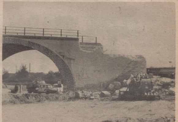
Una grúa, descargando golpes con una bolsa de 1.500 kilos de peso, acabó con el puente en pocos minutos. El problema, sin embargo, no se ha solucionado, ya que hasta que el nuevo puente del ferrocarril se termine, el actual sigue sin permitir el paso de la autovía. ¿Qué va a ser de la estación de servicio? Parece que la autovía lleva prisa.
