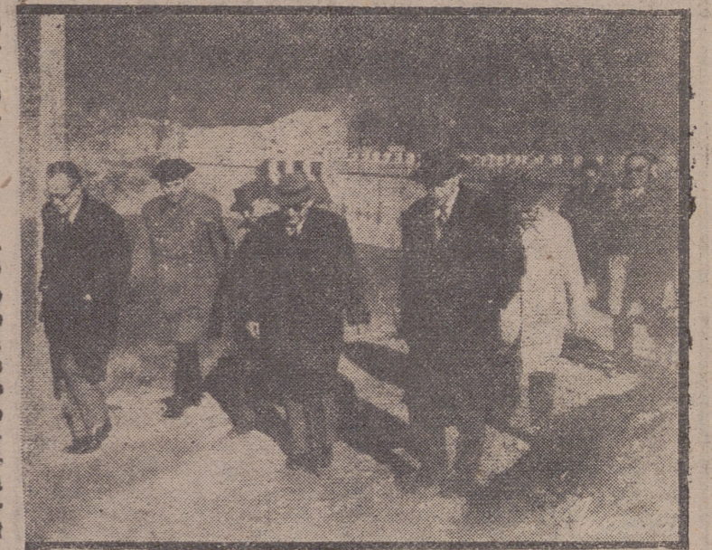
Acompañado del director general de Obras Hidráulicas y de autoridades y personalidades, el señor Vigón recorre las obras del Pantano González Lacasa.
