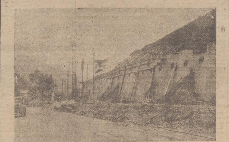
BUSUNGE (León). Vista exterior del túnel artificial que actualmente se construye entre esta estación y el túnel de la Perreca, para evitar la interrupción del tráfico ferroviario con Asturias a consecuencia de los temporales de nieve. (Cifra).
