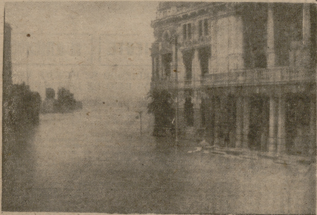
En Cartagena se han producido muy importantes inundaciones, que dan a la ciudad un aspecto casi veneciano. De la gravedad de las mismas da idea esta fotografía, en la que aparece el Palacio Municipal completamente aislado por las aguas, que alcanzaron un metro de altura.
