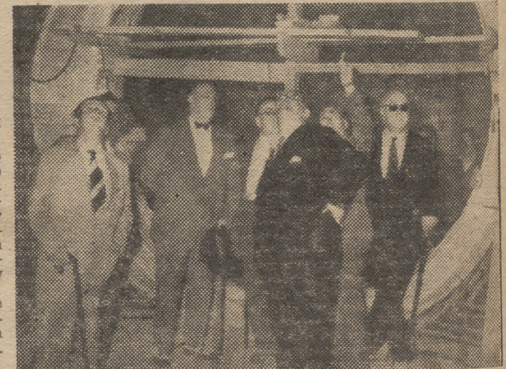
Autoridades de la provincia y técnicos de Eléctricas Leonesas contemplando la chimenea de seguridad del túnel, obra difícil y atrevida, exponente de la capacidad y tecnicismo de nuestros ingenieros
