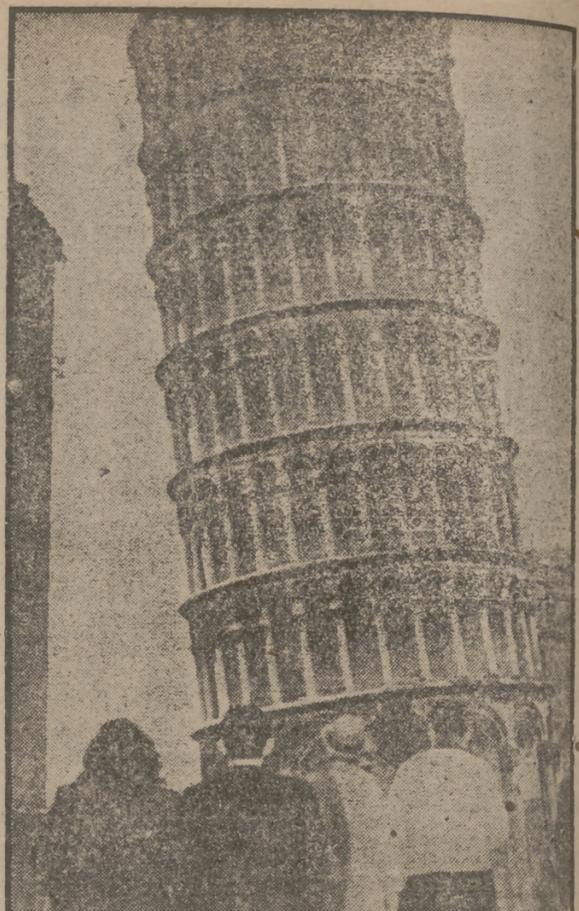
El campanil, visto desde el punto en que la inclinación es más evidente. Desde otros puntos de visión la torre da la sensación de estar inclinada por todos partes. La inclinación del campanil no es uniforme, sino que varía de galería a galería.
