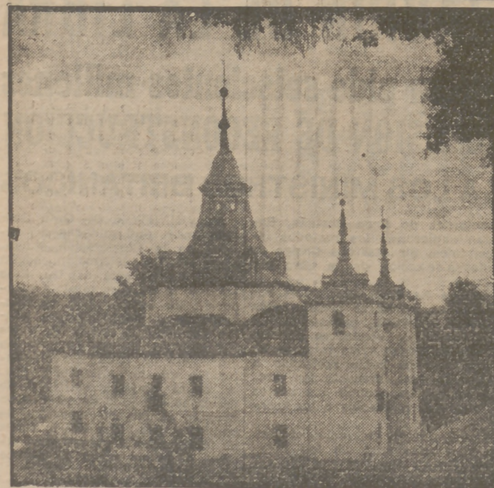
Una vista de dicha ermita, enclavada en la ribera izquierda del Manzanares, que ha sido reconstruida y que próximamente se inaugurará. (Polo Cifra.)
