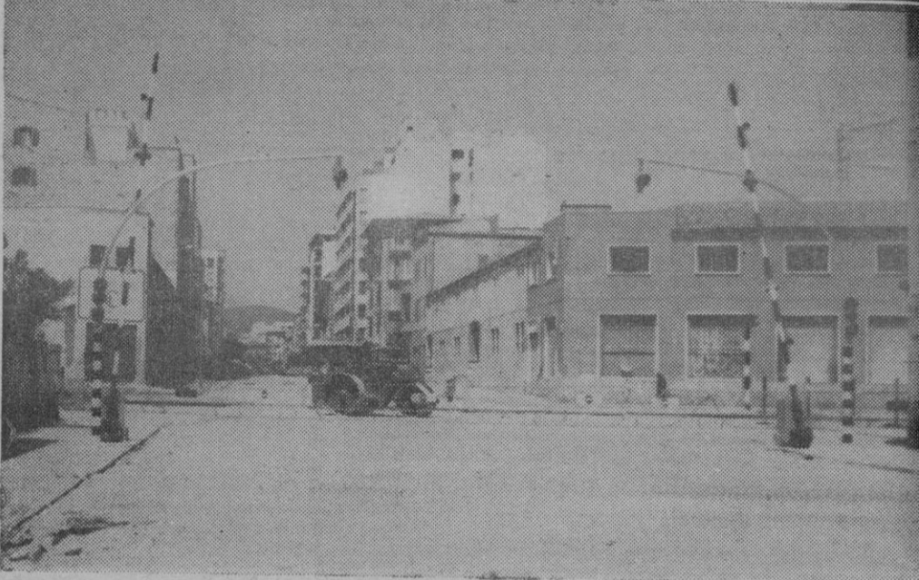
ESTADO ACTUAL DE LAS OBRAS, EN EL NUEVO PASO A NIVEL DE LA CALLE BALMES. PRACTICAMENTE, ESTA YA TODO LISTO SU APERTURA ES COSA DE DIAS. (Fotos Ribas)
