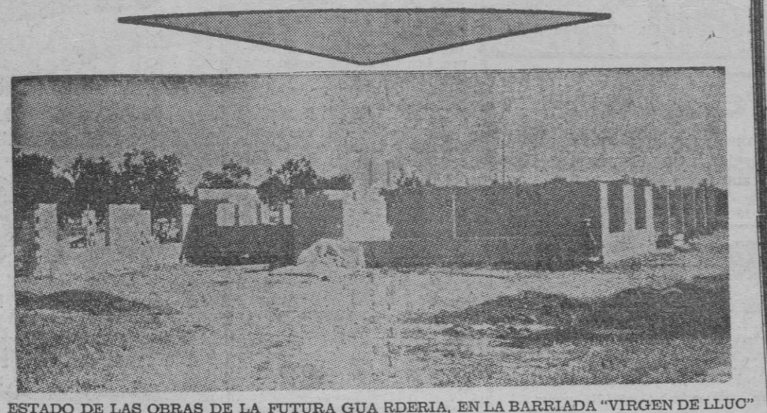
ESTADO DE LAS OBRAS DE LA FUTURA GUARDERÍA, EN LA BARRIADA «VIRGEN DE LLUC»
