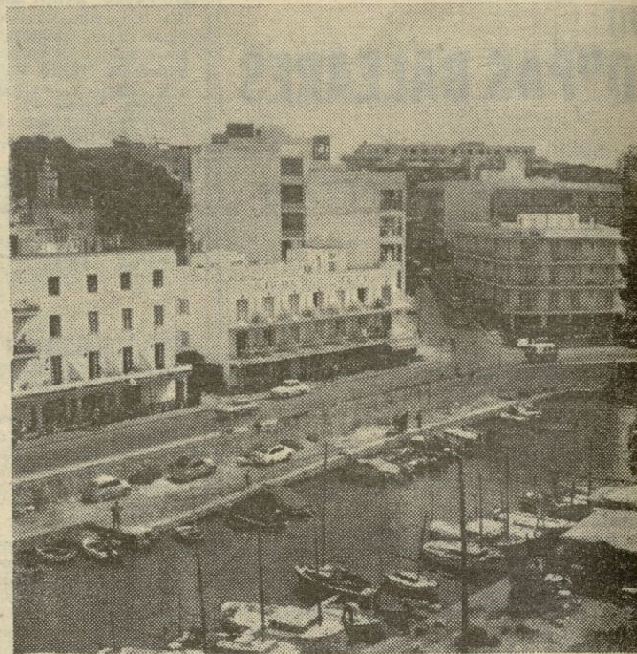
AGUAS NEGRAS ESTAN PERJUDICANDO ESTE TIPICO CLUB NAUTICO. AL FRENTE ESTA LA CALLE DE SAN BARTOLOME, QUE SEPARA EL ARENAL CLASICO CON LA ZONA DE SON VERI. POR ESTE LUGAR DEBERAN INSTALARSE LOS TUBOS QUE LLEVARAN HASTA EL EMISARIO SUBMARINO.
