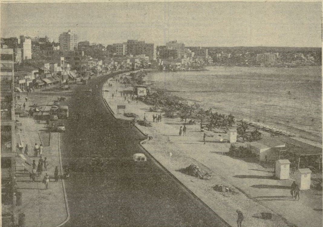
LA PLAYA DE PALMA, EN LA PARTE DEL ARENAL, TAMBIEN SE OFRECE A LOS VISITANTES MODERNA Y ATRAYENTE. PERO CASI NADIE SE DA CUENTA —EXCEPTO LOS PROPIETARIOS DE EDIFICACIONES— DEL PROBLEMA QUE DEBE RESOLVERSE A ESCASOS METROS DE PROFUNDIDAD.
