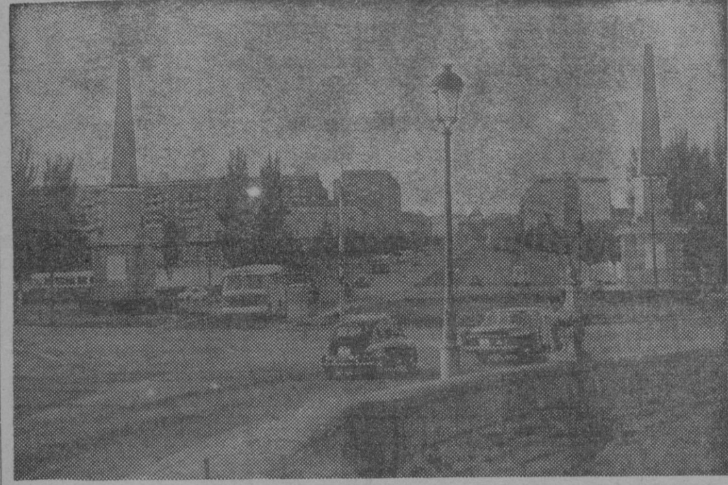
Madrid. — Después de las obras llevadas a cabo en la Glorieta de las Pirámides, se ha abierto al tráfico el paseo central de la misma. (Foto Cifra).
