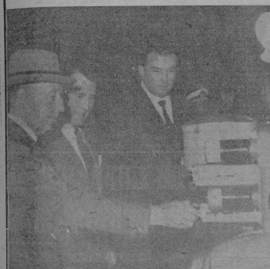
Su Excelencia el Jefe del Estado inauguró el complejo hidroeléctrico de Belesar, cuya presa es la mayor de España, con 129 metros de altura, 332 en la cota de coronación y una capacidad de 640 millones de metros cúbicos. El Caudillo aparece en el momento de pulsar el botón de la puesta en marcha de uno de los grupos de la central. — (Telefoto de Cifra.)
