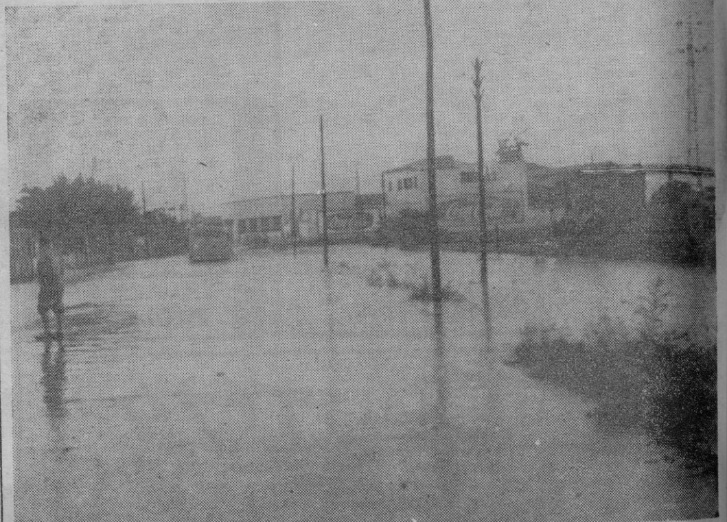
La barriada de La Soledad volvió a sufrir inundaciones. La foto de "Juanet" demuestra como se hallaba la carretera de Manacor poco después de que finalizara la tormenta.
