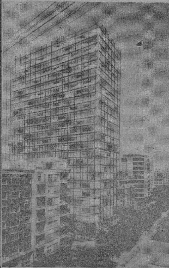
ALICANTE. — En la Avenida de Soto comenzarán en breve las obras de construcción del que se considera será el mayor hotel de España. El edificio tendrá una altura de noventa metros, veintiséis pisos, mil ochenta habitaciones sala de fiestas, piscina cubierta y otra en la última planta. En la foto, el edificio tal como será una vez terminado. — (Foto Cifra.)
