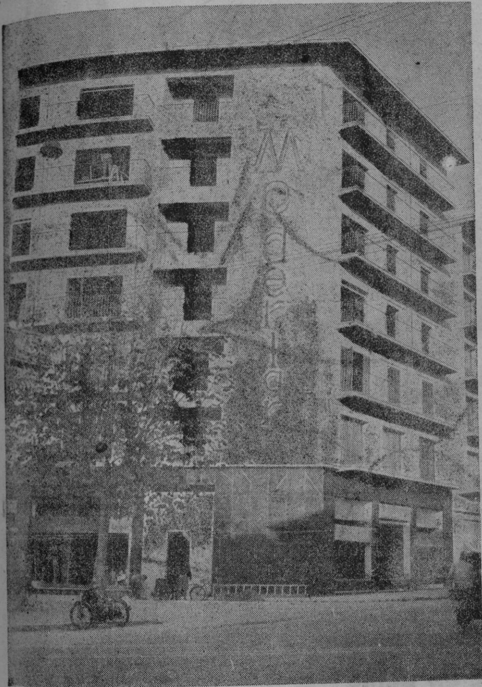
Edificio de MODERLAR
