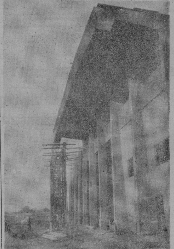
En la parte posterior de la tribuna, el voladizo sobresale 5'40 metros, sirviendo de contrapeso.
