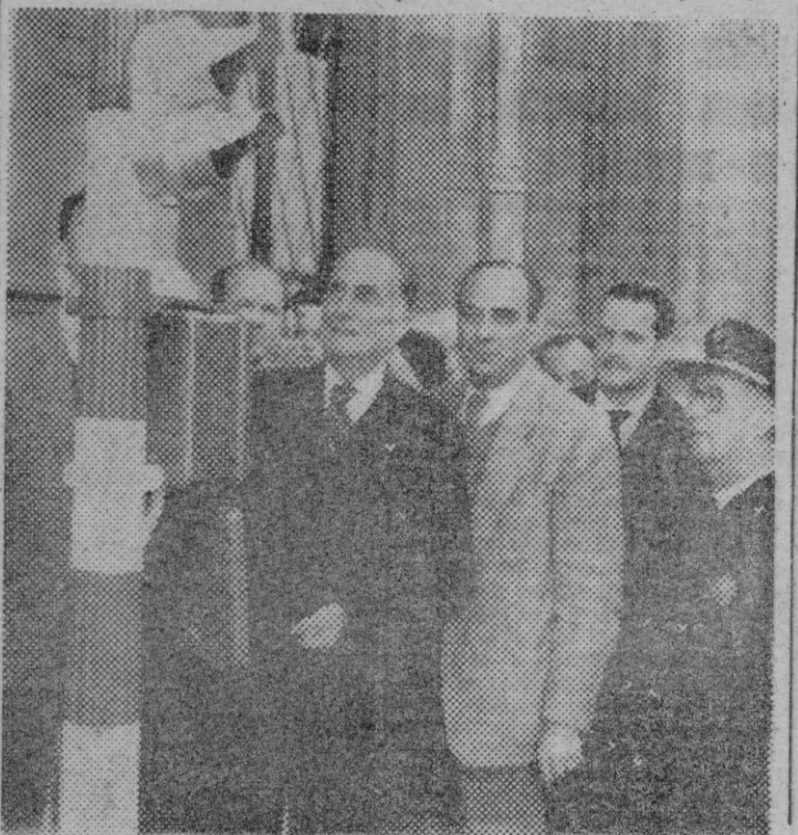
El Alcalde poniendo en marcha los nuevos semáforos instalados en la calle General Goded, junto a la Plaza de Cort
