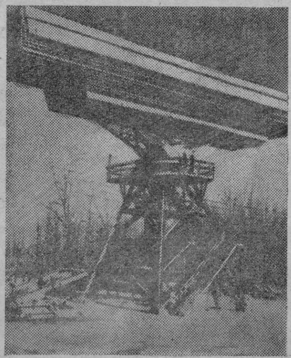
Nueva antena de radar, capaz de registrar la presencia de aviones a miles de millas de distancia, que ha pasado a formar parte de la red de defensa del mando aéreo estratégico de los Estados Unidos. Tiene un peso de 50 toneladas y descansa sobre un andamiaje de metal, con altura de tres pisos.
