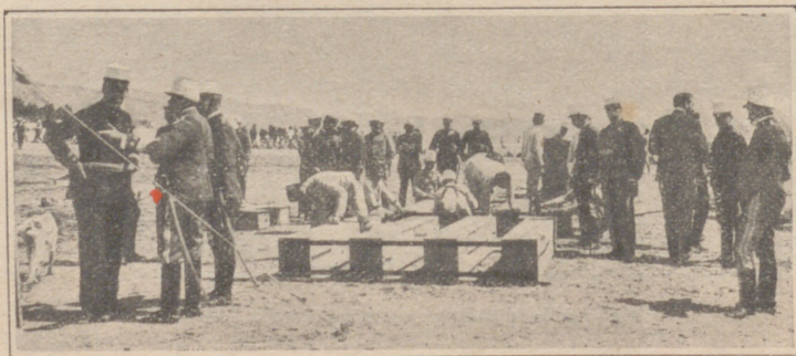
Construcción de la balsa.
