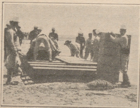
Construcción de la balsa.
