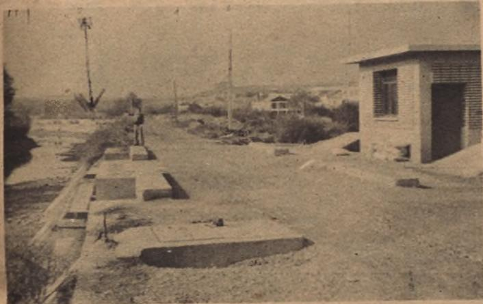
En la foto de nuestro corresponsal puede apreciarse el nuevo emplazamiento de la compuerta de desagüe del Canal por la que vierte el exceso de caudales hacia el Ebro a través del barranco que atraviesa la población. Al fondo y señalado con una flecha, el emplazamiento de la antigua compuerta.
