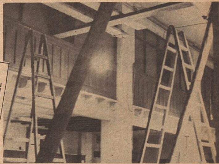
Una vista de una de las aulas, donde grupos de obreros están realizando diversos trabajos para conocer el estado real de las techumbres, que amenazaban con desprenderse.
