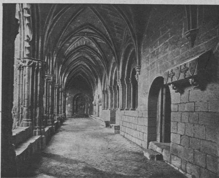
Nave de la sala capitular
