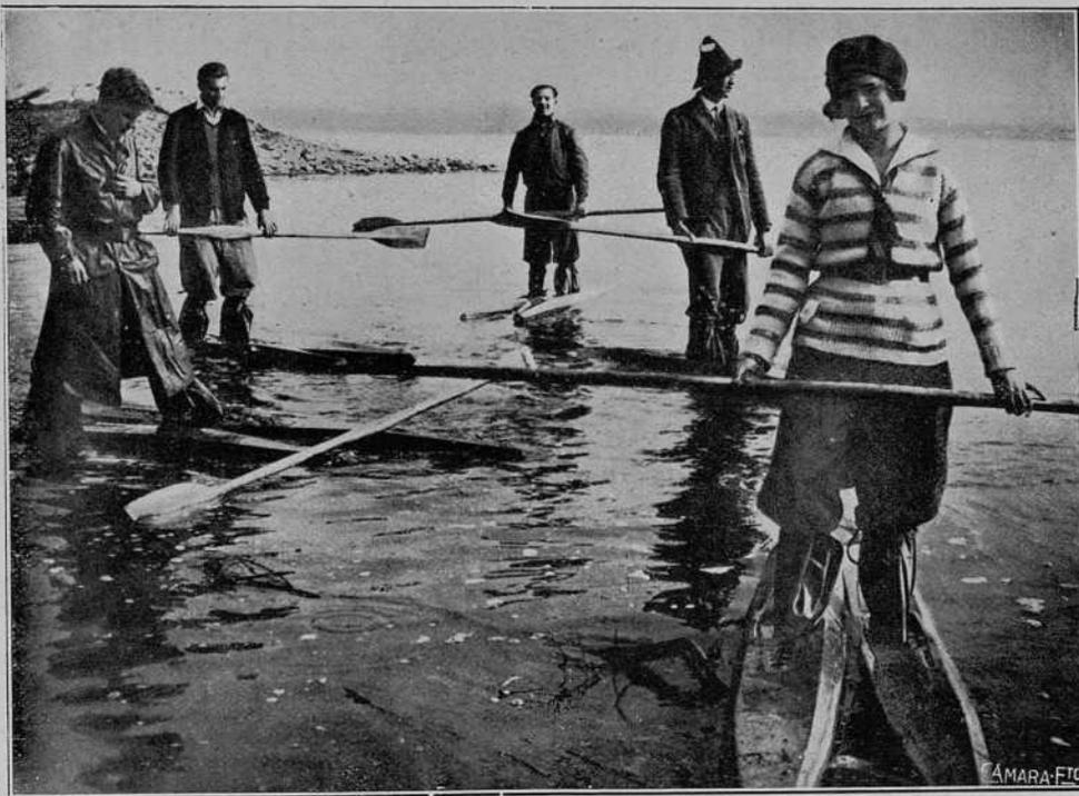
Durante la pasada semana se han efectuado, con pleno éxito en el Danubio, entre Klosterneuburg y Hainburg, los ensayos del hidro-ski, ó deslizador acuático, inventado por un mecánico alemán. Componen el aparato dos flotadores de la misma forma que los skis alpinos, asegurándose la propulsión mediante el empleo de remos. El invento ha sido favorablemente acogido por los devotos del deporte, á los que el hidro-ski abre nuevos horizontes en sus actividades.
