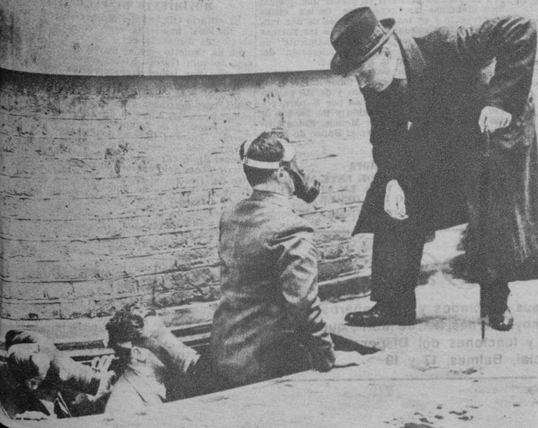
LA CONSTRUCCION DE REFUGIOS ANTIAEROS EN LONDRES
