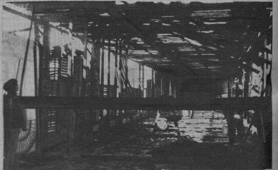
Dos aspectos del incendio de una fábrica de tejidos.—En La Riera (Tarragona), se ha quemado la fábrica de tejidos propiedad de don Luis Sedó, habiendo sido de consideración las pérdidas. Han sido destruidas dos salas de telares. El incendio ocurrió la mañana del día 16, de las diez a las once horas. (Fots. Piortiz)
