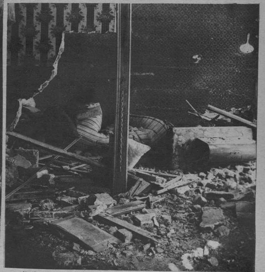
Destrozos en la casa contigua al C. A. D. C. I. — (Fots. Maymó)
