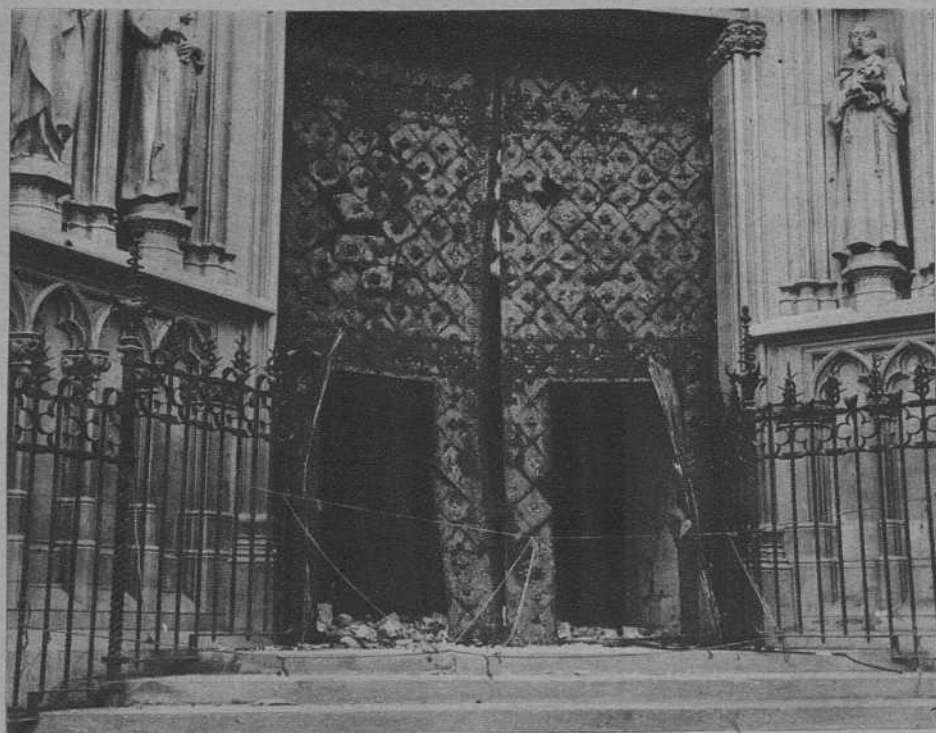
Puerta principal de la Basílica de Santa María, que no habiendo podido ser abierta por los rebeldes, lo fué por el incendio
