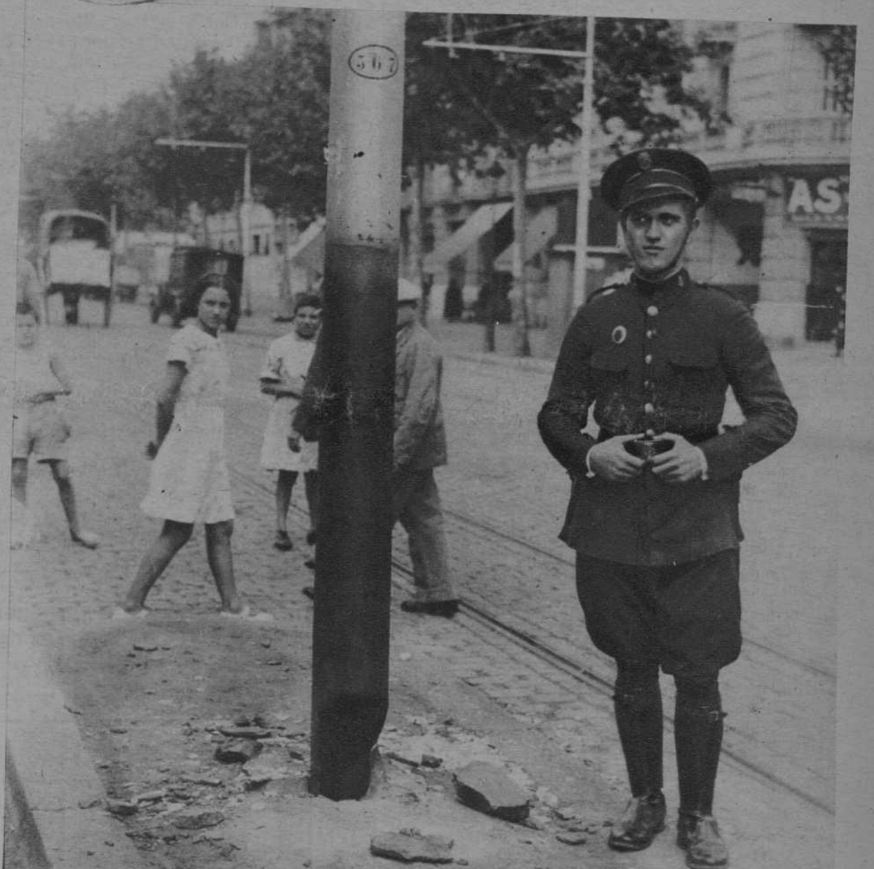
Desperfectos ocasionados por la explosión de un artefacto en el poste de tranvías del Paralelo. (Fot. Merletti)
