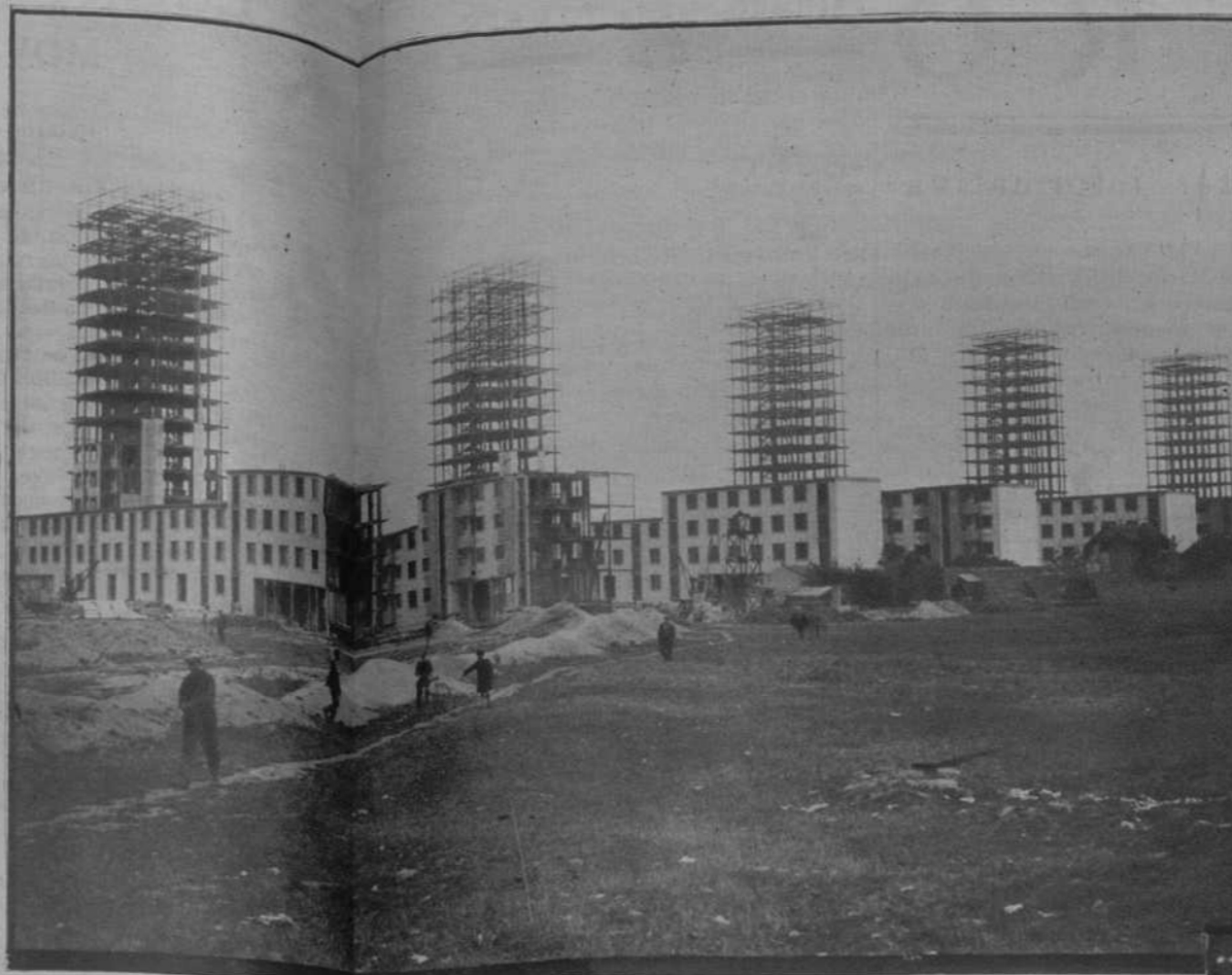
París.—Casas baratas que se están construyendo en Drancy.—(Fot. Keystone)
