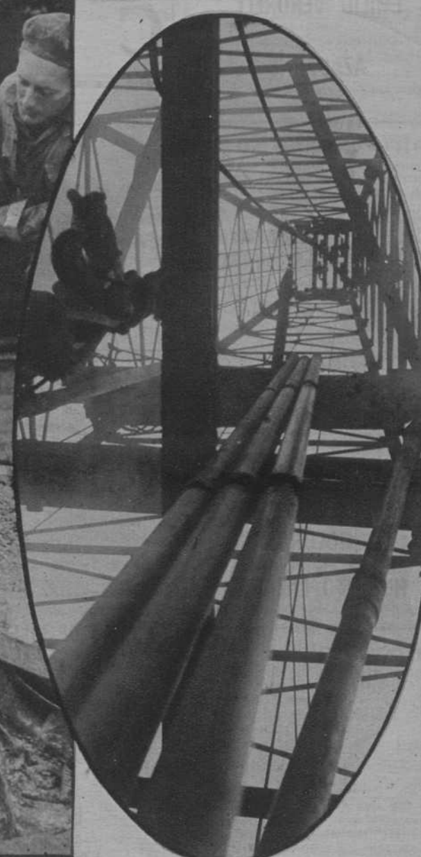
París.—Los tubos colocados para extraer el agua del pozo artesiano de 831 metros de profundidad
