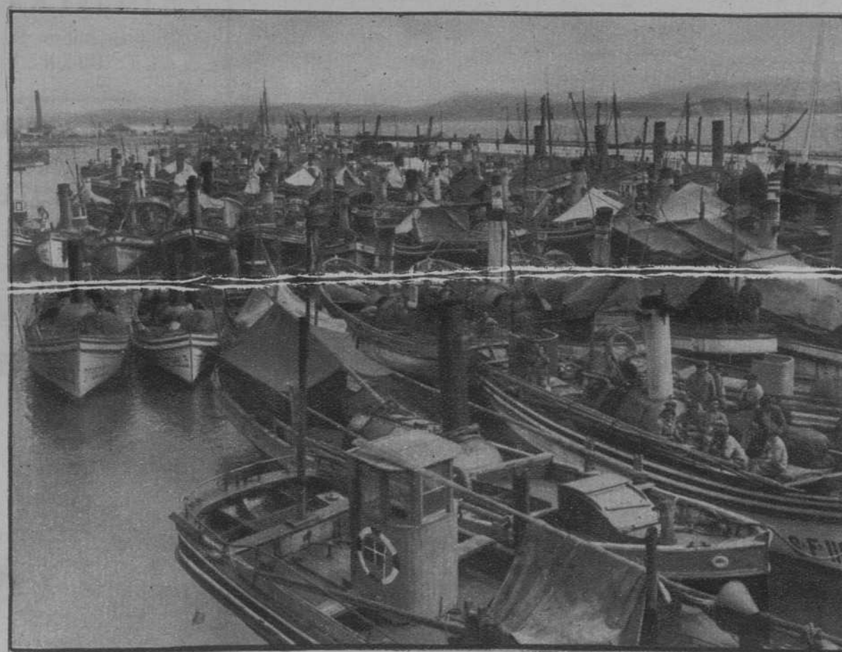
Santander. — Aspecto de Puerto Chico, donde están refugiadas las embarcaciones pesqueras, a causa del temporal. — (Fot. Samot)
