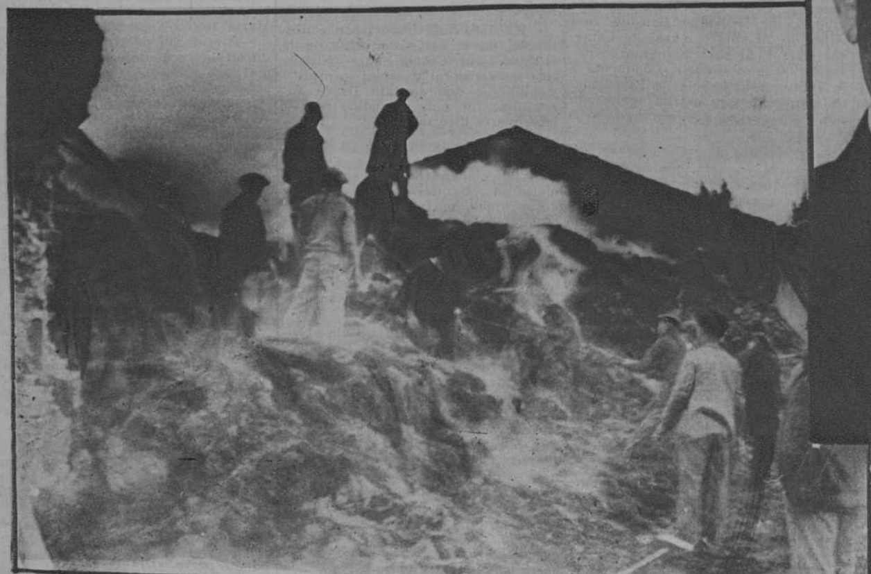
Foyos (Valencia).—Dos vistas del incendio provocado en la fábrica Yutera Española, a causa de la explosión de 25 bombas. Al derrumbarse la pared sobre la vía del tren eléctrico Valencia-Masamogrell, quedó interrumpida la circulación. (1). Más de de mil balas de yute quemadas (2). (Fots. Bondia)
