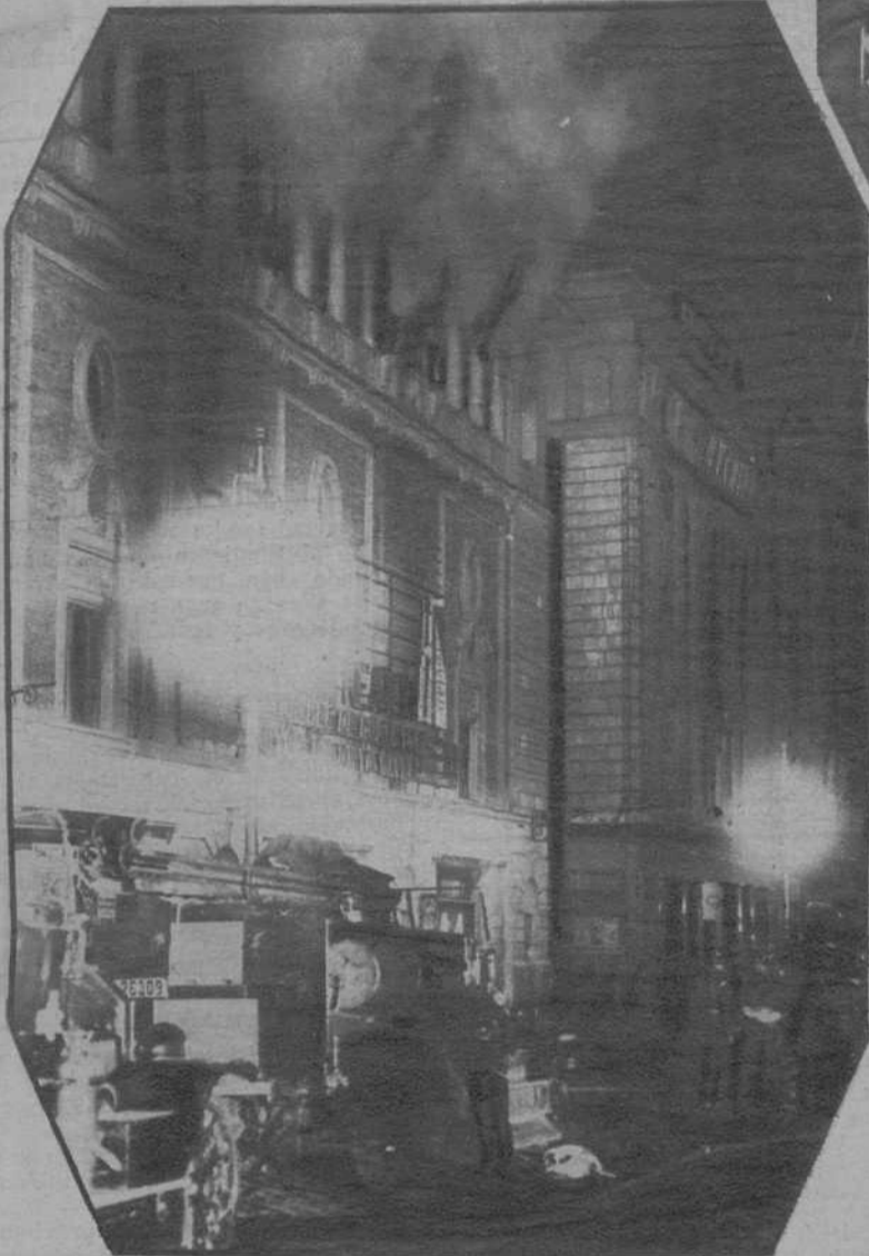
EL INCENDIO DEL PALACIO DE LA MUSICA, DE MADRID.—Vis- ta exterior del edificio, durante el incendio
