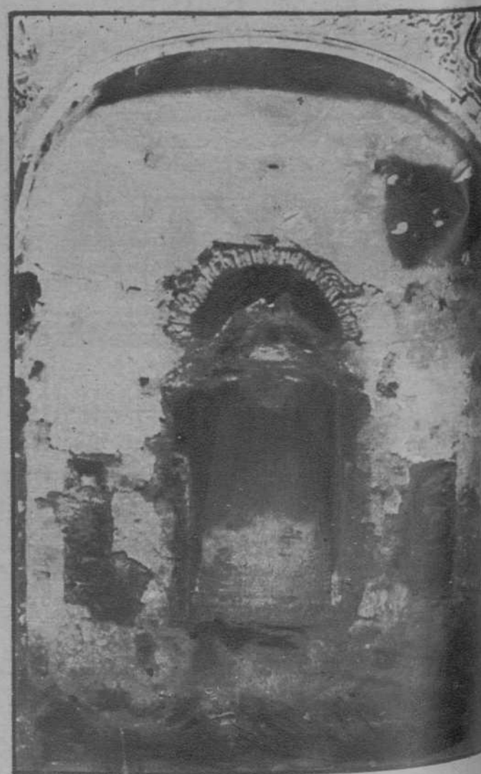
Córdoba.—Estado en que quedó la capilla del Sagrario.—(Fots. Santos)
