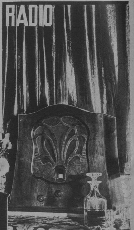
Nuevo receptor Superheterodino de 8 válvulas con regulador automático de volumen. Chasis equilibrado montado sobre caucho. Placa terminal para conexiones de Pick-up y Altavoz extra. Precio (c. a.) 1.150 Pesetas.
