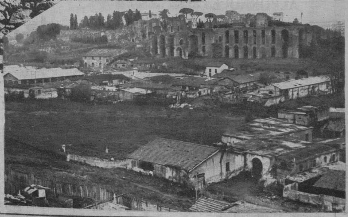
Excavaciones en el lugar donde estuvo enclavado el «Circo Máximo»
