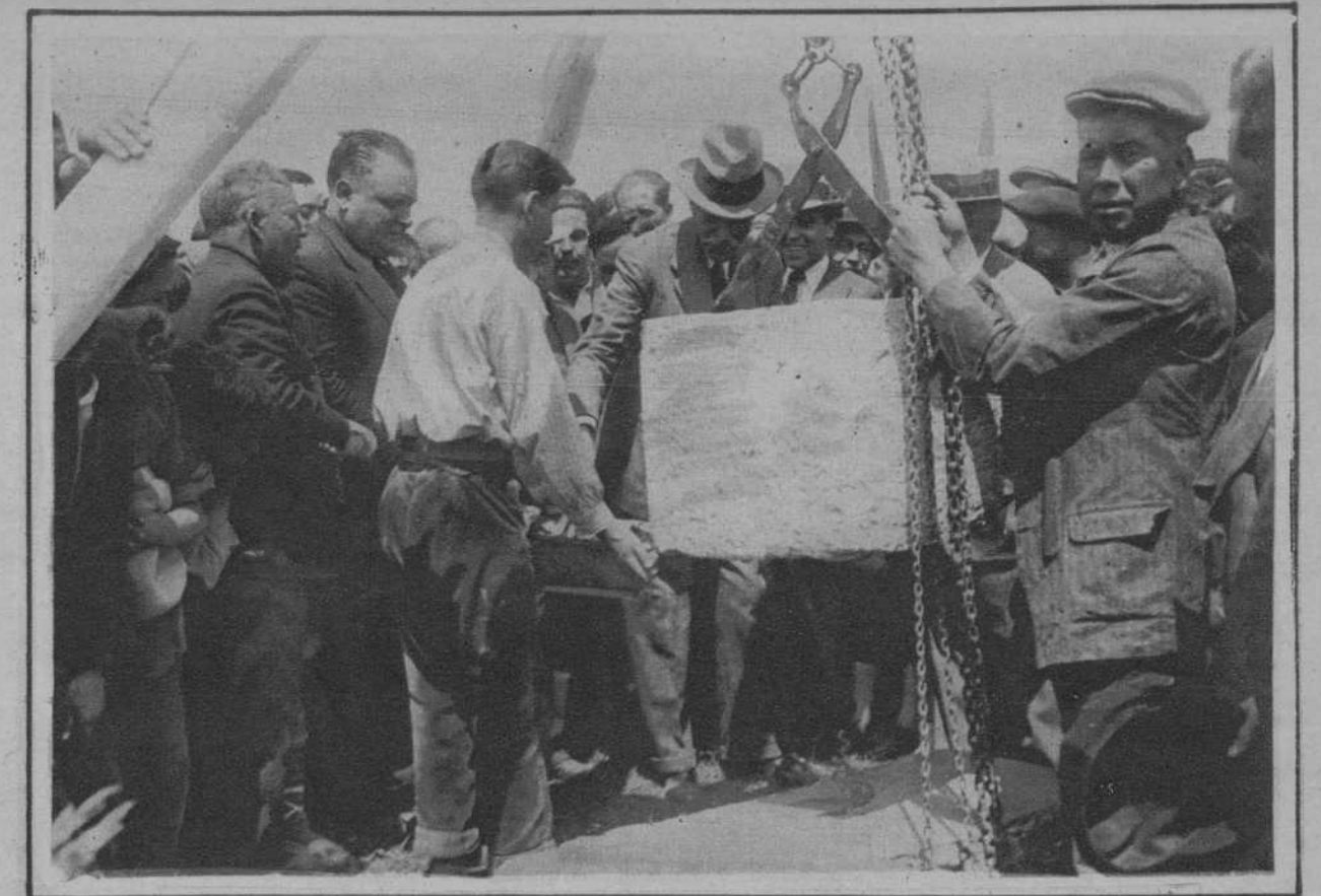
Santa Coloma de Queralt.—El Presidente de la Generalidad, don Francisco Maciá, colocando la primera piedra de las obras de construcción de las nuevas escuelas (Fot. Domínguez)
