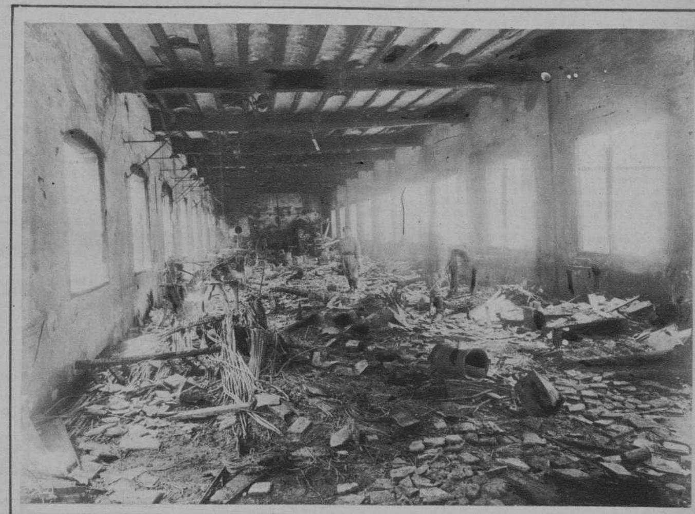
Estado en que quedó el edificio de la calle de Carretas, completamente destruido por un incendio, en la tarde del viernes. — (Fot. Merletti)
